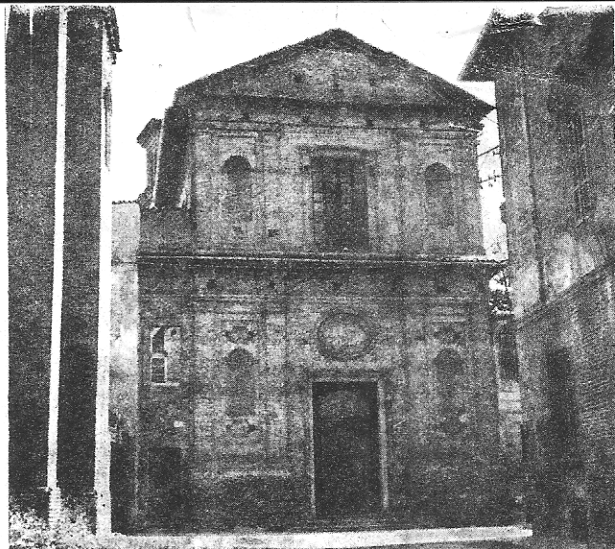
La chiesa di S. Eustacchio in via del Consiglio. Sulla sinistra sono visibili alcune paraste della Chiesa di S. Lorenzo; sulla destra parte del Palazzo di Giustizia
