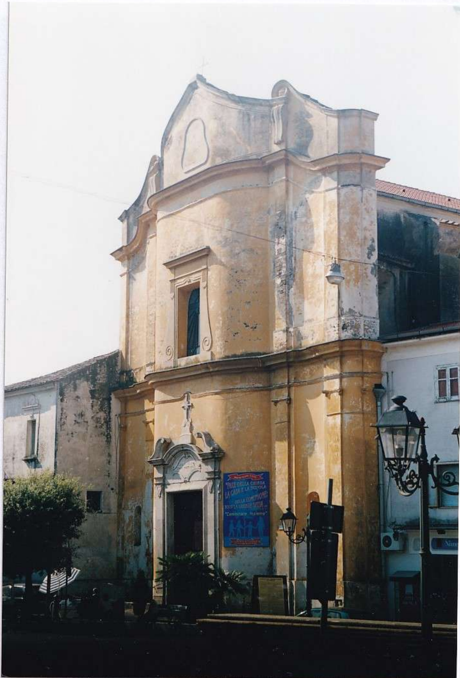
FOTO n° 1 - Vista facciata esterna: frontale (2003)
