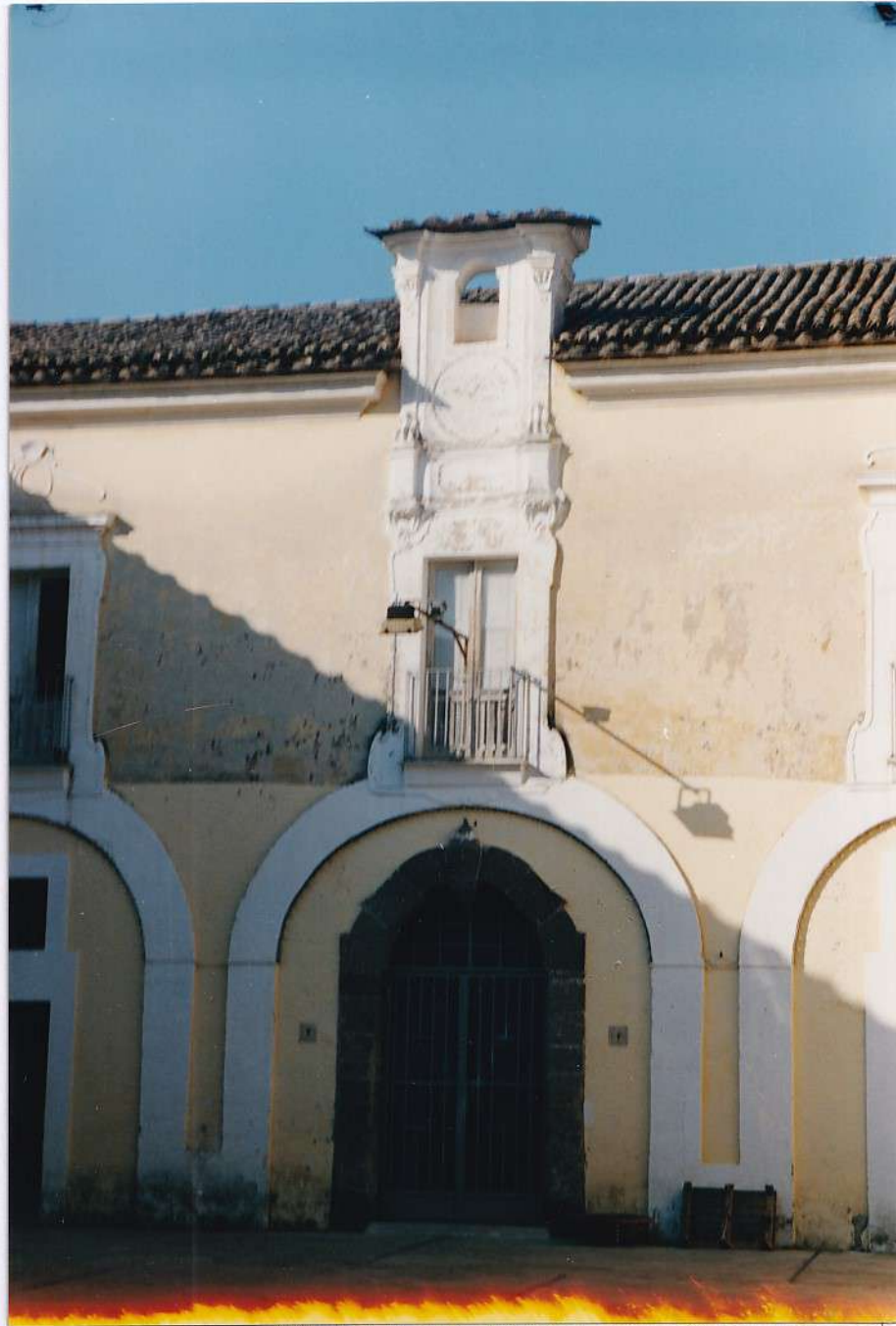
FOTO n° 4 - Prospetto Nord-Ovest sulla corte (2003)
