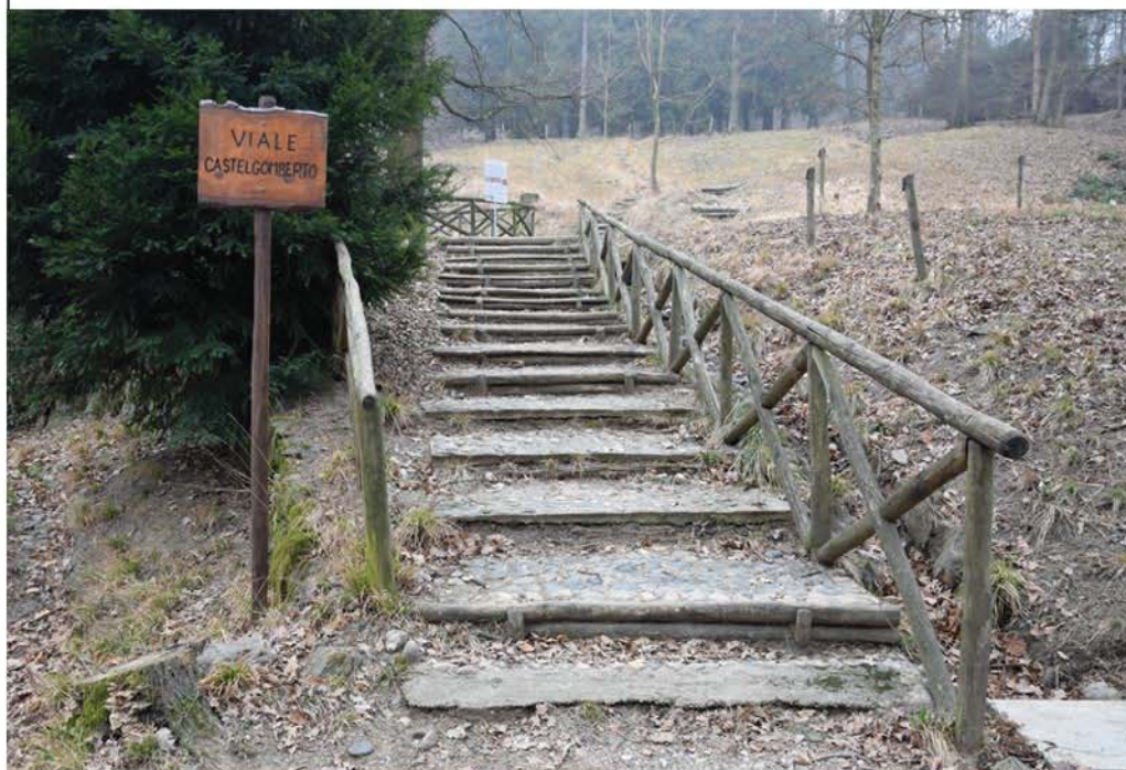
1- Viale Castalgomberto. Punto iniziale
