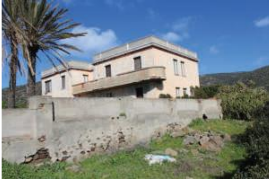
Immobile denominato "Palazzina Sanità" a Cala Reale nell'Isola dell'Asinara: fronte sul lato interno (lato giardino)
