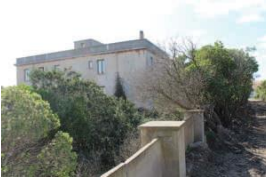
Immobile denominato "Palazzina Sanità" a Cala Reale nell'Isola dell'Asinara: fronte laterale sul lato strada
