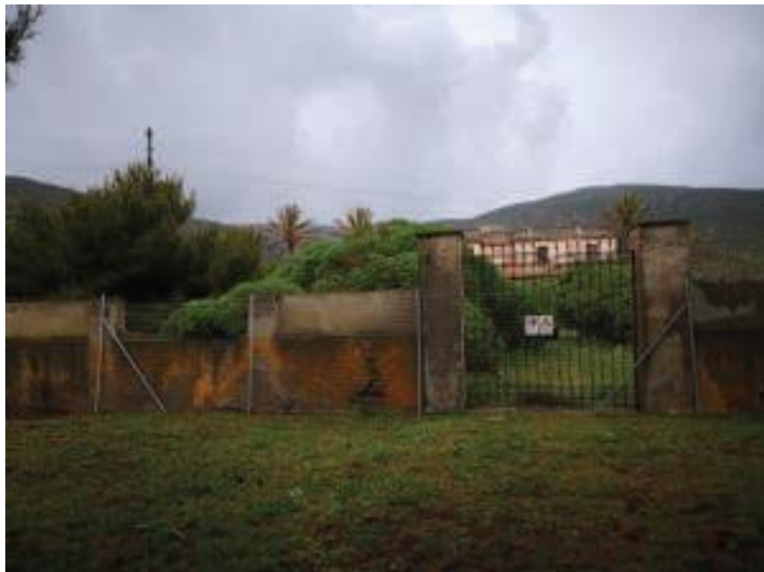
Immobile denominato "Palazzina Sanità" a Cala Reale nell'Isola dell'Asinara: accesso alla Palazzina sul muro di cinta dell'area a verde
