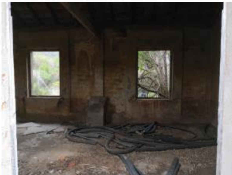
Immobile denominato "Palazzina Sanità" a Cala Reale nell'Isola dell'Asinara: annesso con destinazione magazzino (interno)
