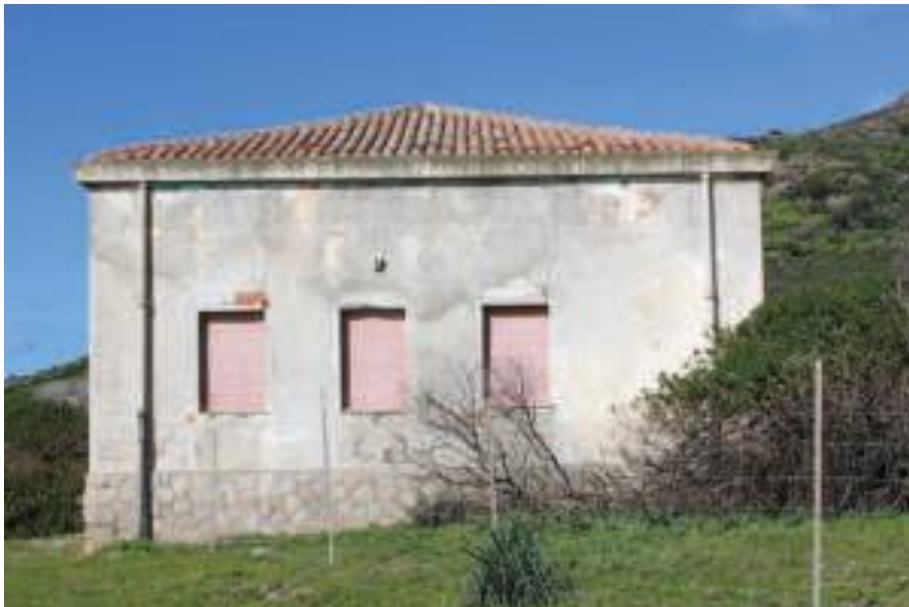
Immobile denominato "Ex Scuola" a Cala Reale nell'Isola dell'Asinara: dettaglio del prospetto sul lato corto, aule.
