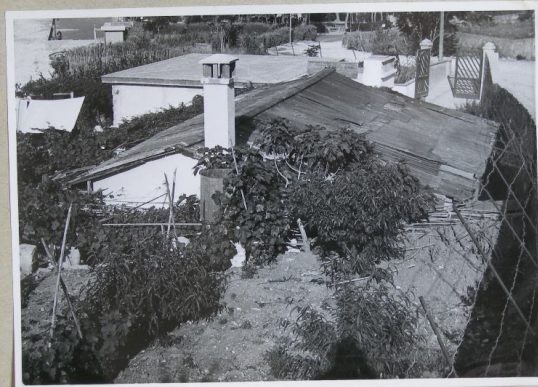
Sirocco - Portoferraio - Viale G. Pietri - veduta dello stabilimento balneare abusivamente costruito - (pratica N° 701)
