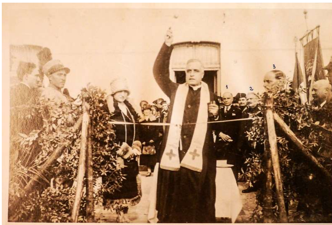
BAD – Fototeca Briamo – Brindisi Parco della Rimembranza. Benedizione e taglio del nastro http://www.brundarte.it/2019/06/16/parco-della-rimembranza-brindisi/
