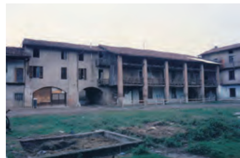
t. 11 Stal del Colabiöl de sóta. Il corpo Nord visto dall'interno. La statua della Madonna del Colabiolo di sotto era custodita nel sottotetto più alto sulla sinistra, nel solaio che dava su Via Garibaldi (fot. Riccardo Scotti, apr. 1986)
