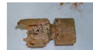
t. 54 Il perno interno compromesso dai tarli (gen. 2012)
