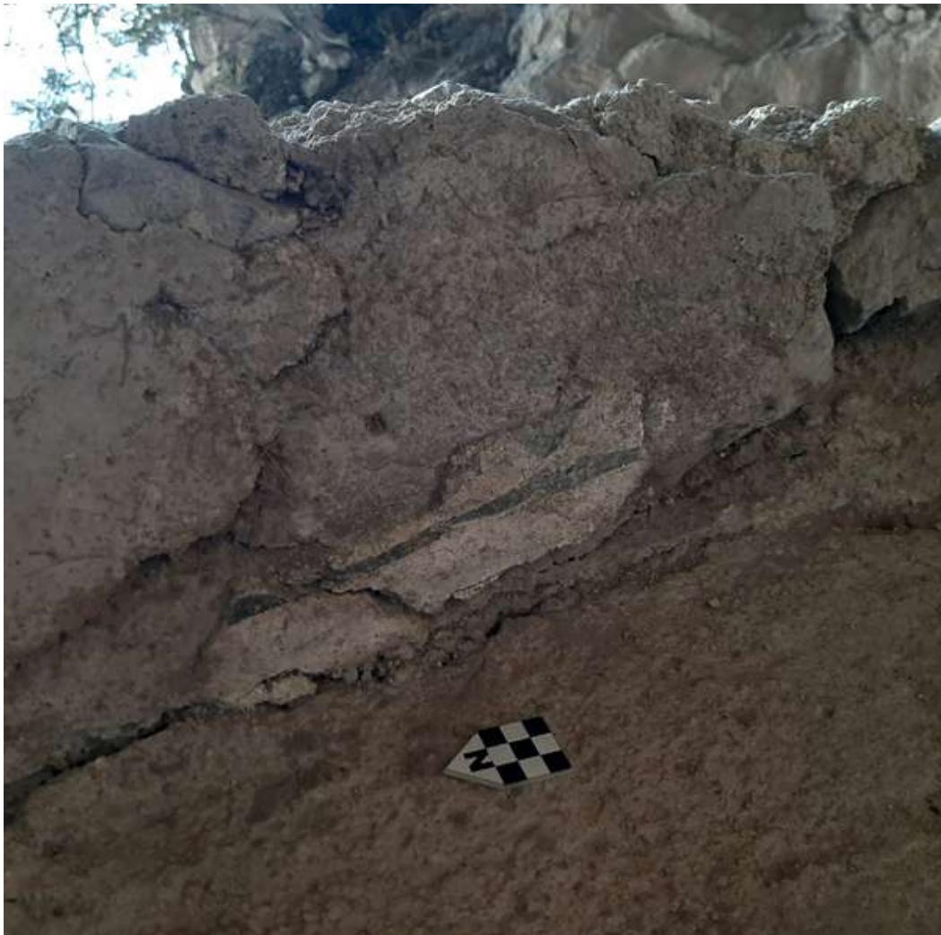
Figura 11: veduta da N-W dell'intonaco dipinto del sedile USM 25 della parete Est dell'ambiente A. Foto di B. Del Mastro.
