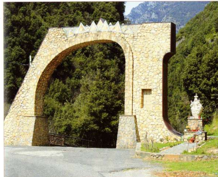
L'arco in pietra che segna l'ingresso alla via del Rosario
