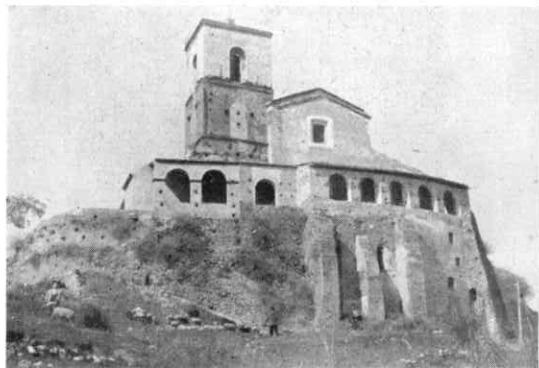
Fig. 1 - S. Maria del Castello: facciata con cripta fra le due monofore (sec. XII) e, sopra, «le logge».
