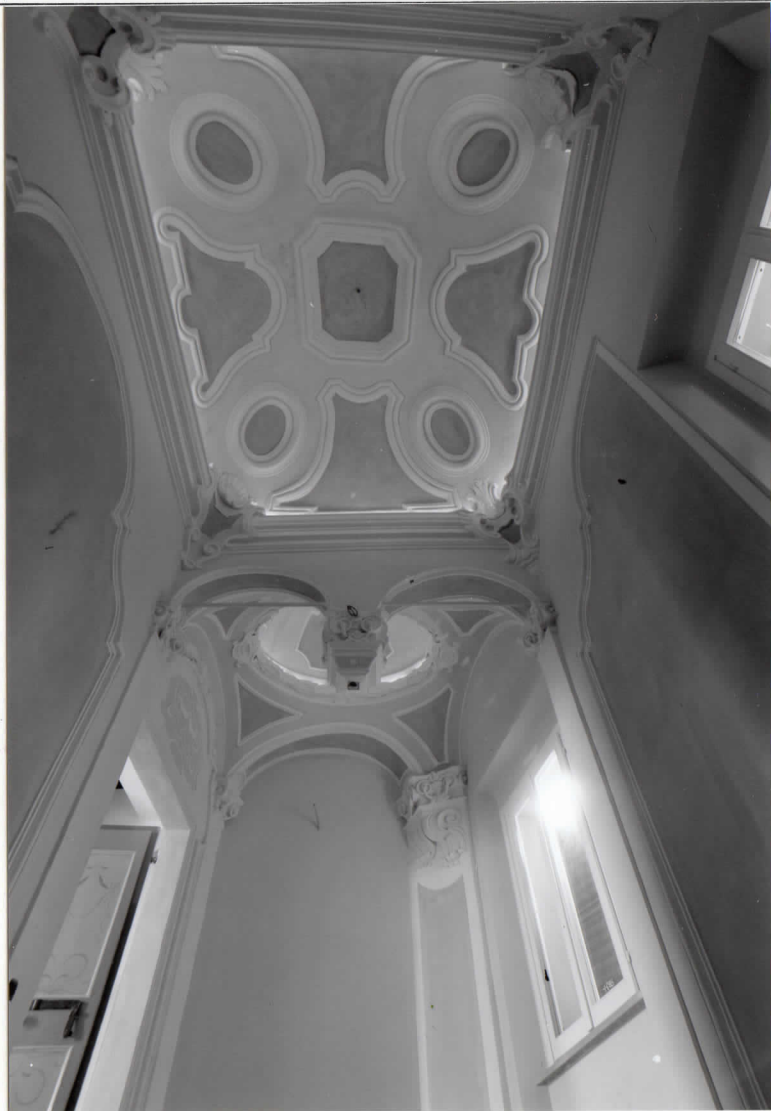
VANO SCALA - PARTICOLARE DEL SOFFITTO
