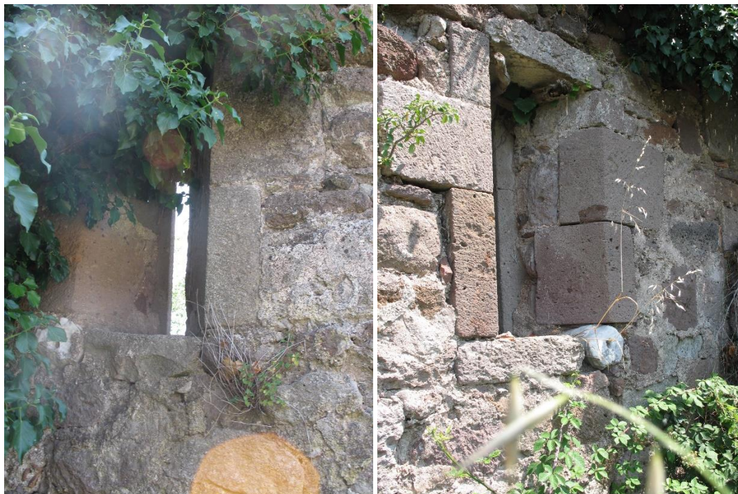
Chiesa di San Sergio. Particolare della monofora sulla parte laterale destra. Vista dall'interno e successivamente dall'esterno dell'aula (foto 2011)
