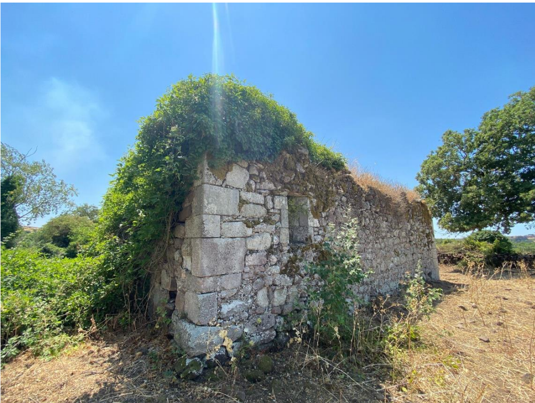
Chiesa di San Sergio. Parete laterale sinistra e parte posteriore
