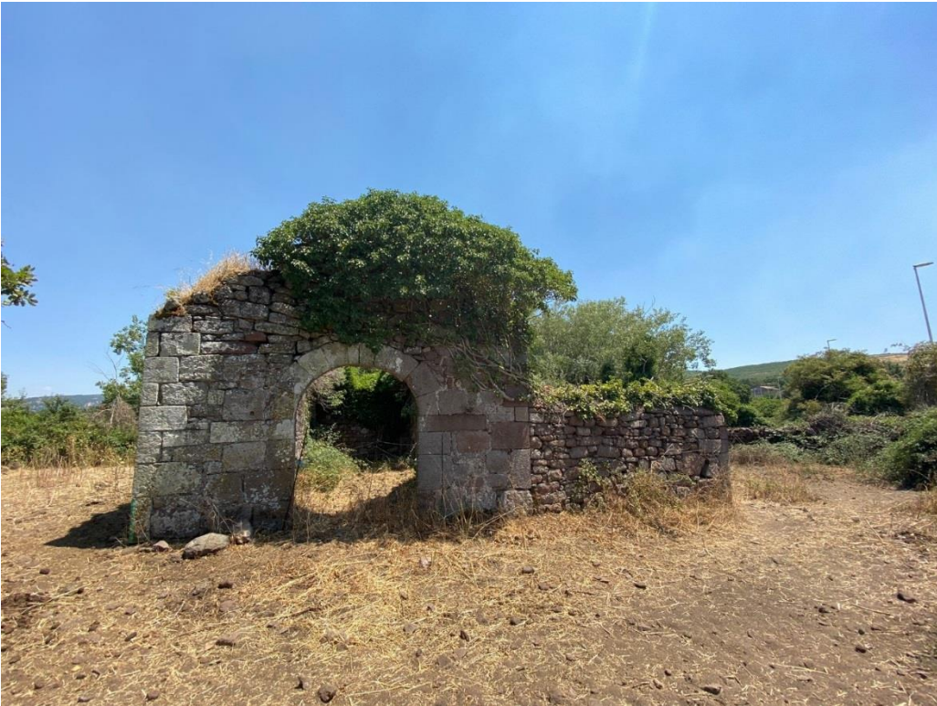
Chiesa di San Sergio. Vista della facciata principale e corpo laterale
