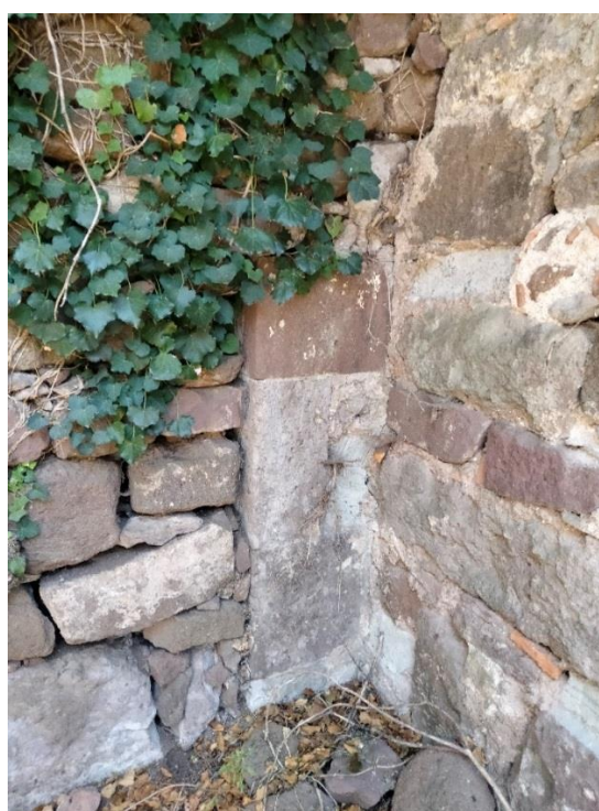
Chiesa di San Sergio. Particolare attacco abside (dx) parte laterale sinistra. Vista dall'interno dell'aula
