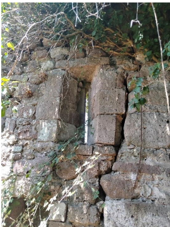
Chiesa di San Sergio. Particolare monofora sulla
