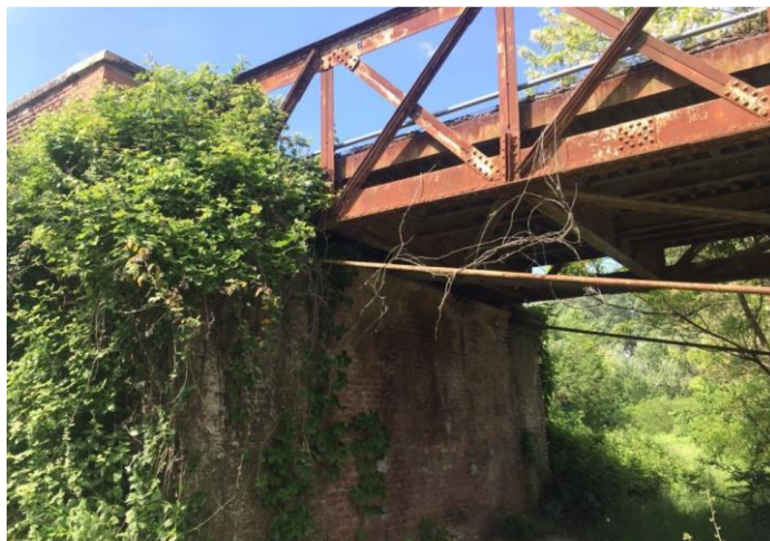
Dettaglio delle spalle in muratura
