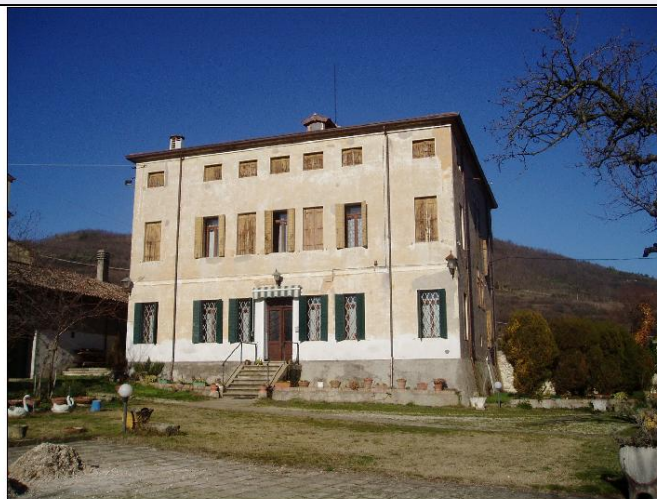
Ripresa fotografica n. 6: prospetto Sud veduta dal cortile interno
