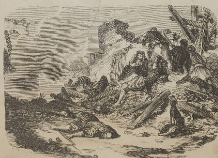
Presca al incendio di Messina. 7 settembre 1848.
