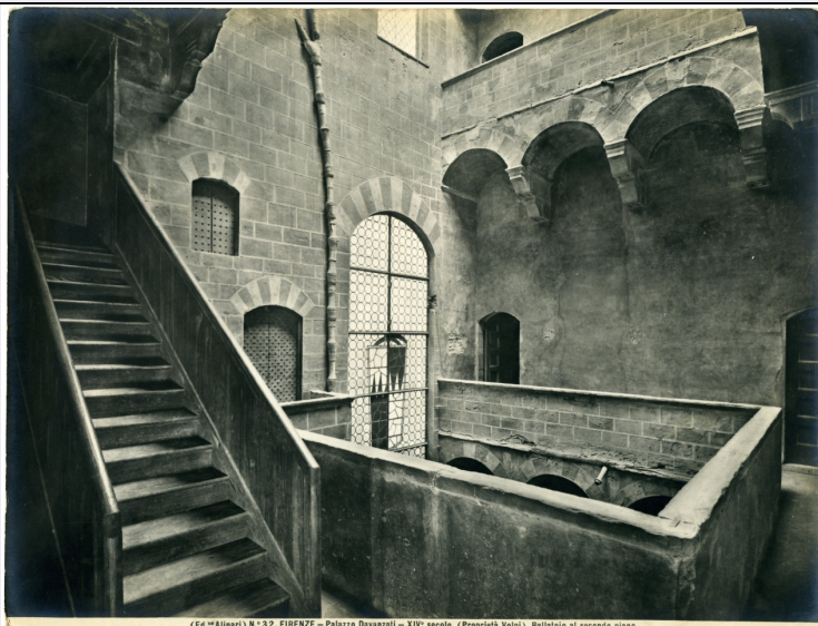
(Ed. Allinari) N.° 32. FIRENZE - Palazzo Davanzati - XIV° secolo. (Proprietà Volpi). Ballatoio al secondo piano.
