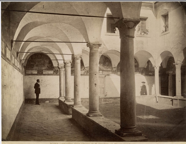
ROMA - Cripta della Chiesa di S. Onofrio al Monte Giordano
