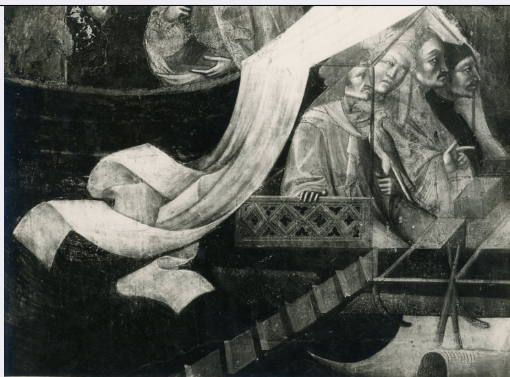
9926-S01.0032A-C, Petronio-SB0, XV- Dettaglio del Ritorno in Oriente M. Cressi
