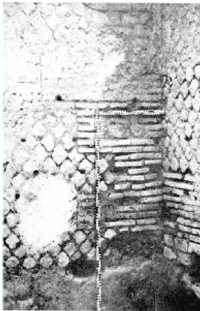
Fig. 33 - Vue de l'angle Sud des latrines.
