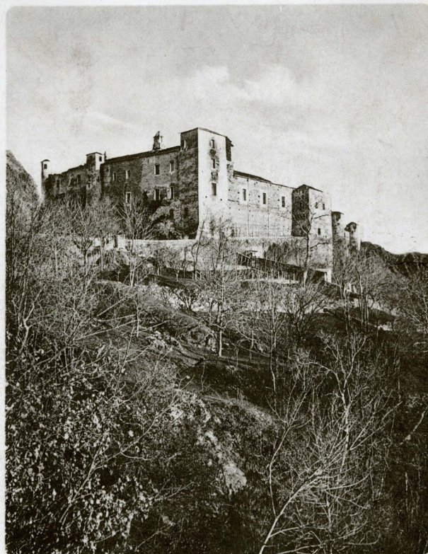
Château de Quart, fondé en 1185 par Jacques II. de Porte Saint-Ours (Aoste) berceau des deux B. B. Emeric Evêques d'Aoste, le 1 er de 1301 à 1313 et le 11 ème de 1361 à 1375
