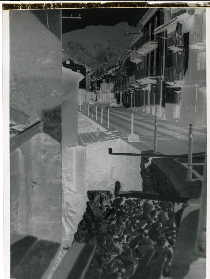
ES228 - SAINT-VINGENT (AO) - ALLARGAMENTO STRADALE
