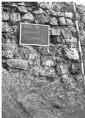
Fig. 7 - Particolare della tecnica muraria della seconda torre.
