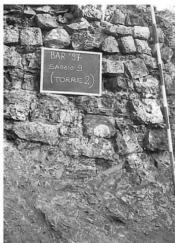
Fig. 7 - Particolare della tecnica muraria della seconda torre.
