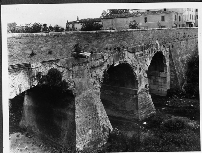
Sarignano sul Rubicone - Ponte dal primo stradale a valle - 27-8-36
