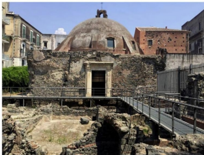
11 Catina (Catania). Terme della Rotonda. Vano 5. Prospetto meridionale.
