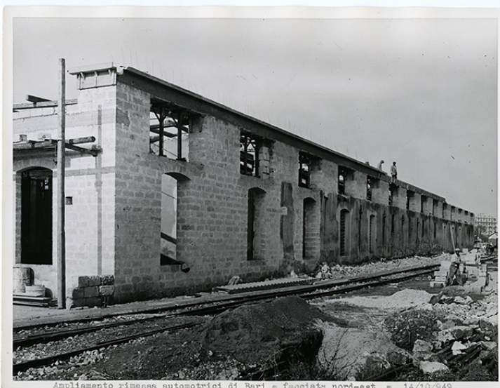
Ampliamento rimessa automotrici di Bari = facciata nord-est = 14/10/949
