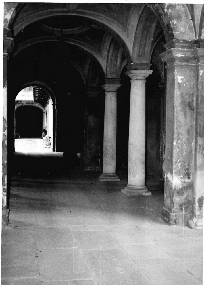
Pilastri e colonne dell'atrio
