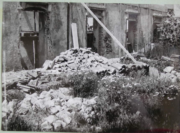
Livorno - Portoferraio - Villa dei Mulini - Teatro di Napoleone - durante i lavori di restauro.
