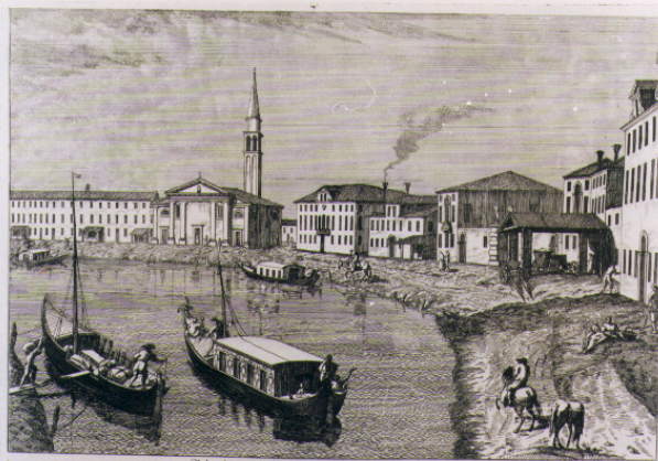
Veduta della Chiesa della Misericordia al Volo.
