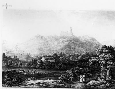
DIE BOYNEBURG Ansicht von der Datschpfelle.
