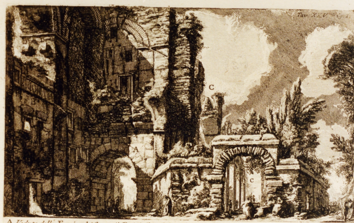
A Veduta della Fornice de' Consoli Dolabella, e Silano investita dagli archi Neroniani provenienti dal Condotto dell'Acqua Claudia. B Avanzo della Iscrizione di Nerone ne' suoi archi. C Proseguimento degli stessi archi. D Modelli di travertino serviti all'elevazione della fabbrica, e lasciati per i fortuiti riguardamenti. Tavola de' disegni. Tav. XXXI.
