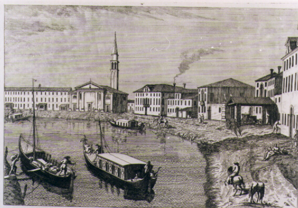
Veduta della Casa della Posta al Doło. IV
