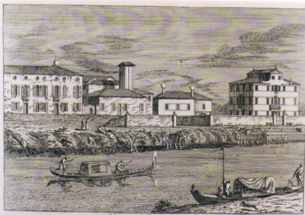
Veduta della Villa di Palluolo. XX
