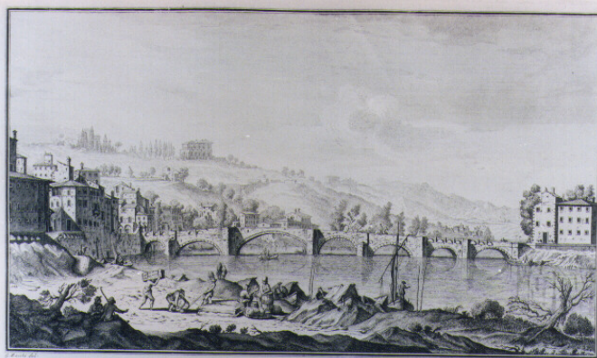
Il Ponte a Signa dalla parte di Levante
