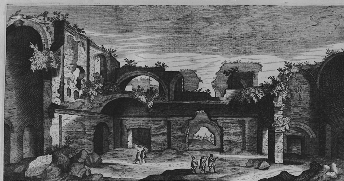
Veduta delle Terme di Antonina e Faustina della parte di dove giace ora un Arco, con un cortile, con un cortile atorno, e intorno da colonne di granito, e portici sopra, le volte nel frontone murate con arco pinnacoli di marmo, li quali furono incassati di diverse pietre mischi, e veda che non uede alcun luogo vestigio, ne gliano che a tempo di Papa Paolo III furono ritrovati in detto cortile, li quali frangiò stacco di marmo, di vetro, di altri, l'anno 1600, e fu fatto il Card. Tomaso ha fatto di nuovo aggiugnere nel suo Palazzo. Marco Jader scultore.
