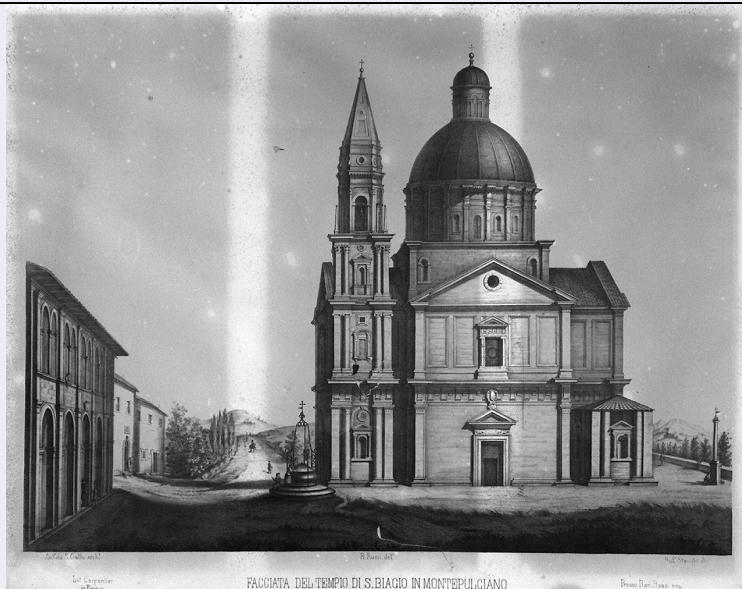
FACCIATA DEL TEMPIO DI S. BIAGIO IN MONTEPULCIANO
